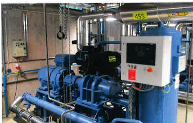
GEA lieferte für das Eissportzentrum drei einstufige Schraubenverdichter vom Typ SP1 SB-5A.
