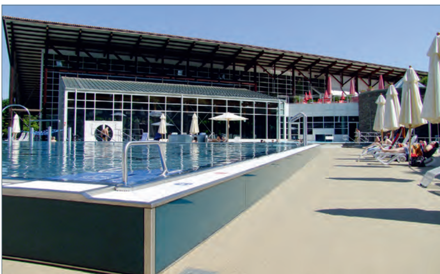
■ Neu auf altem Grund: Beckenumgang und Bodenbelag, ...
