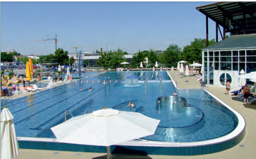
■ Die komplett sanierte Badeplattform
