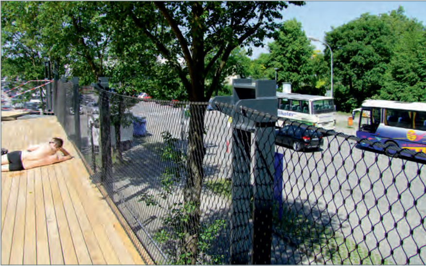
■ ... und die kaum wahrnehmbare Absturzsicherung aus Stahlnetz
