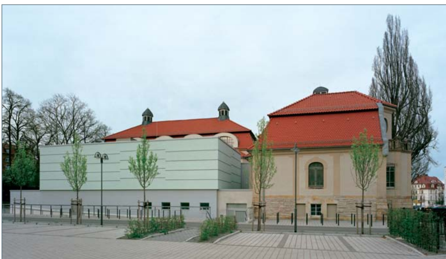
■ Ensemble von Westen mit Altbau und neuem Saunakubus
