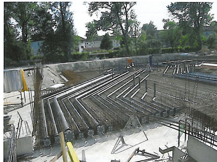
▲ Rohre im Beckenboden – zum Betonieren mit Wasser gefüllt und unter Druck © Möller + Meyer Gotha, Dirk Hartisch
