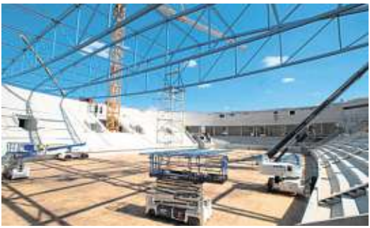
Tonnenschwere Träger wurden im August 2012 über das Dach gelegt. Archivfoto: Alfred Drossel
