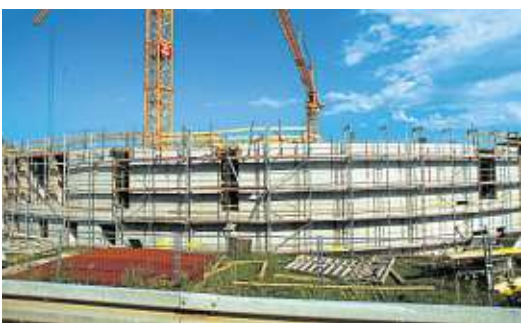
Im Juni 2012 hatte der Bau schon richtige Formen angenommen. Archivfoto: Alfred Drossel
