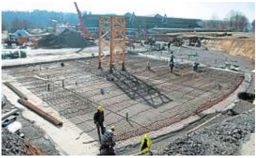
Im Schnitt waren täglich 80 Arbeiter auf der Baustelle (Februar 2012). Archivfoto: Alfred Drossel
