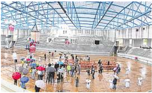
Die imposanten Fischbauchträger sorgten beim Richtfest Ende August 2012 für staunende Gesichter. Archivfoto: Holm Wolschendorf
