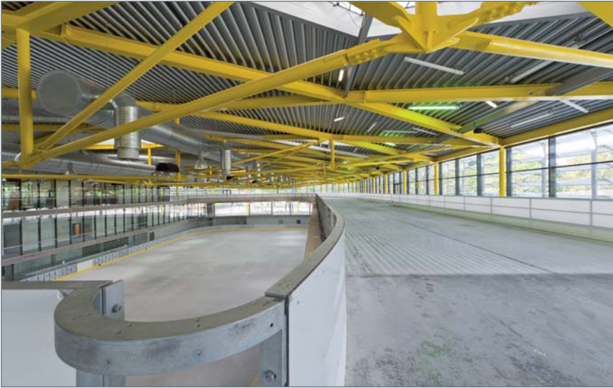
■ Eishochbahn und Eisfläche
